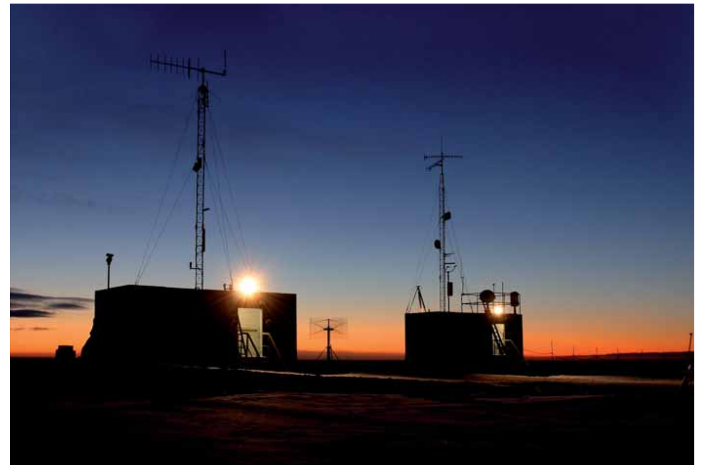
Die Station Neumayer II, wo Christine Läderach 15 Monate lebt und forscht. Der Grossteil der Station befindet sich unterirdisch im ewigen Eis. Im Bild sind die Treppentürme der Empfangs- und Sendemasten in der Polarnacht.
